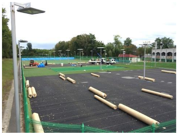
人工芝の全面張り替え工事中
