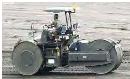
転圧用のロードローラー(ネットより)
