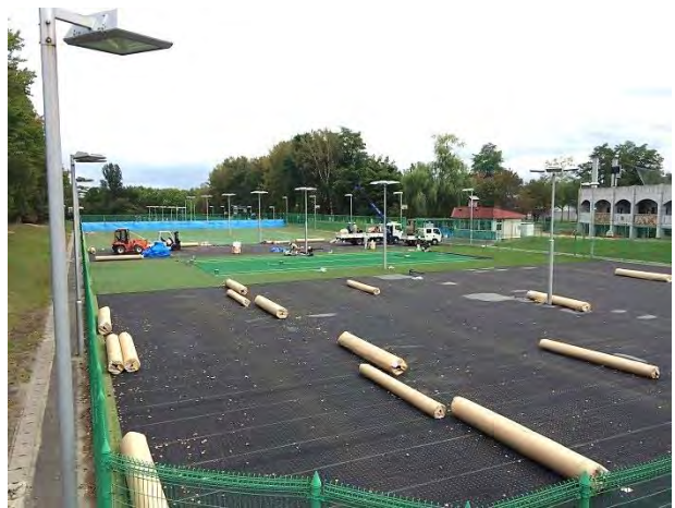
人工芝の全面張り替え工事中
