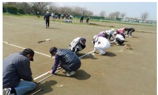
ラインテープ釘打ち風景(ネットより)
